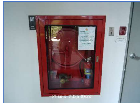
รูปที่ 2.25 ถังดับเพลิงชนิดมือถือ และตู้ดับเพลิง
