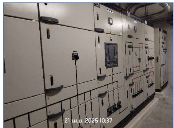
รูปที่ 2.17 ตู้ MDB Main Distribution Board
